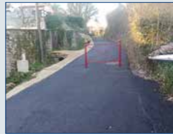
Après les travaux
